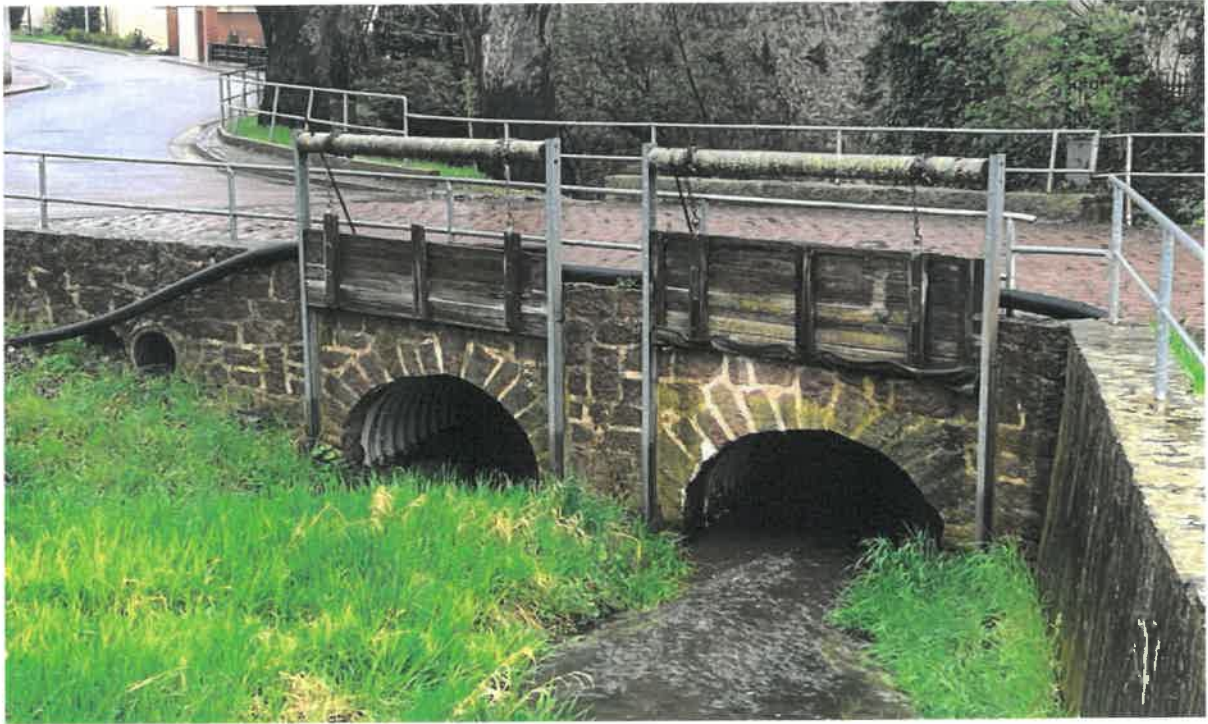
Historische Doppelstauanlage in Teicha
